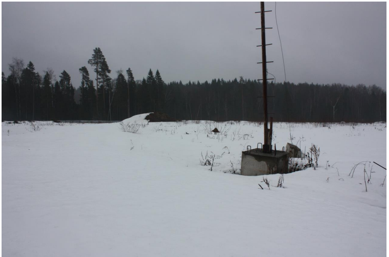
Рис. 3.1.2. Общий вид фундамента опоры наружного освещения
