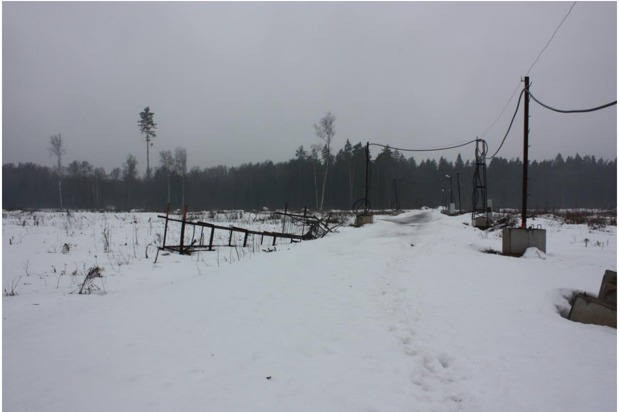
Рис. 3.1.1. Общий вид временной дороги с опорами наружного освещения
